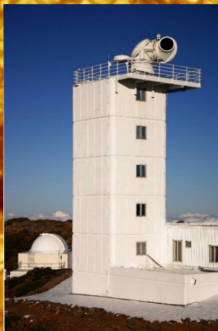
Torre solar sueca, telescopí al buit d'1 m de diàmetre. El Roque de los Muchachos (La Palma) Resolució : ~70 km
