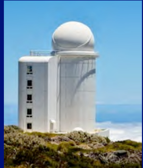
Torre solar (IAC)
